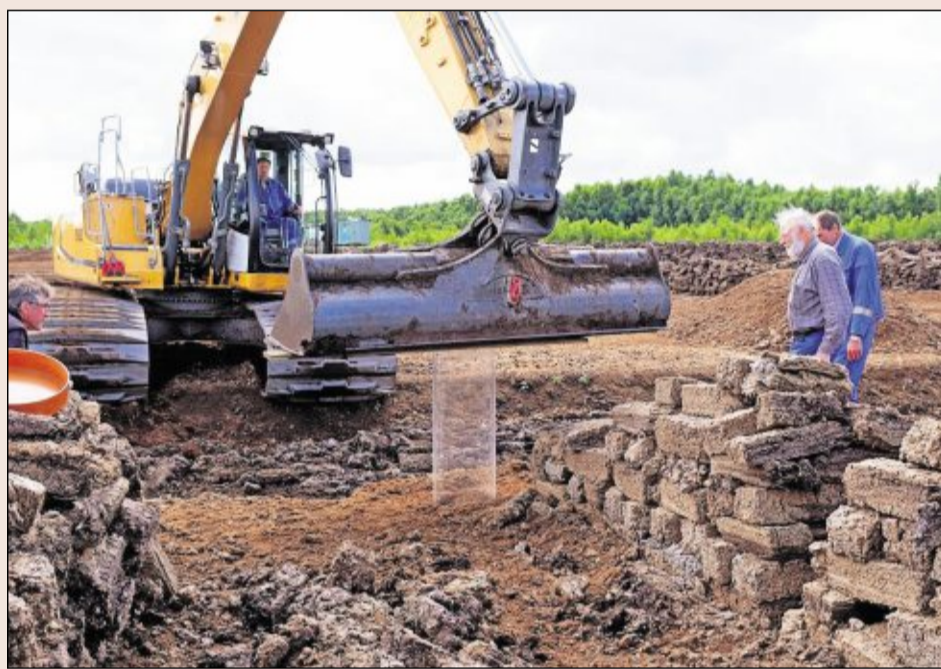
Beim Hineindrücken der Plexiglasröhre in den Torf ist vom Maschinenführer Frank Patjens äußerstes Feingefühl gefordert. Foto: Tonn
